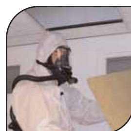
Decontaminazione dell' Amianto
